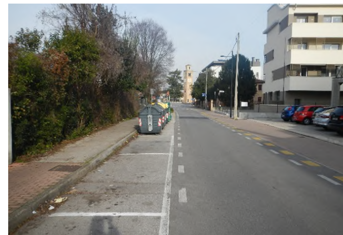
Via Matteotti nord
